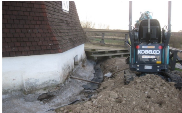
Der graves fri om fundamentet
