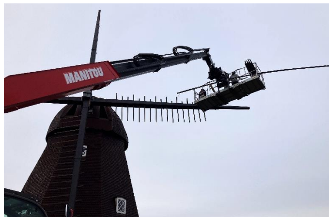
Hækkeværket under montering fra lift (foto Gitte)
