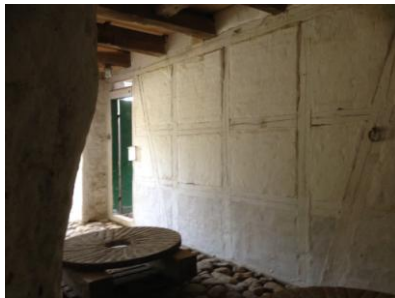
Murværket er genoprettet
