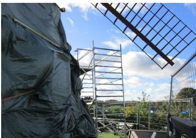
Stillaads der hindrer vingedrejning
